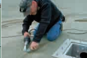
ТРИАК PID со щелевой насадкой при сварке стыков.
